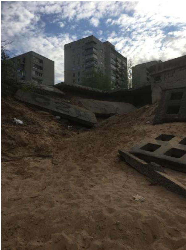
Берегоукрепление (разрушение) г. Рыбинск, ул. Кораблестроителей
