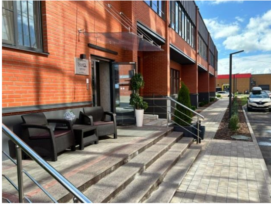
Апарт-отель «Новая Волга» на ул.Волжской-Набережной в современном центре Рыбинска, открыт в 2024г.
