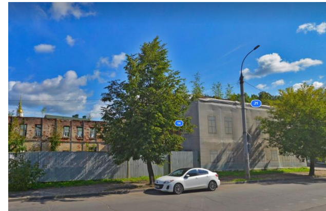
Реконструкция зданий «усадыбы Журавлева» под 5* гостиницу на ул.Стоялой (исторический центр)
