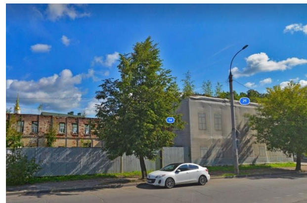
Реконструкция зданий «усадьбы Журавлева» под 5* гостиницу на ул.Стоялой (исторический центр)
