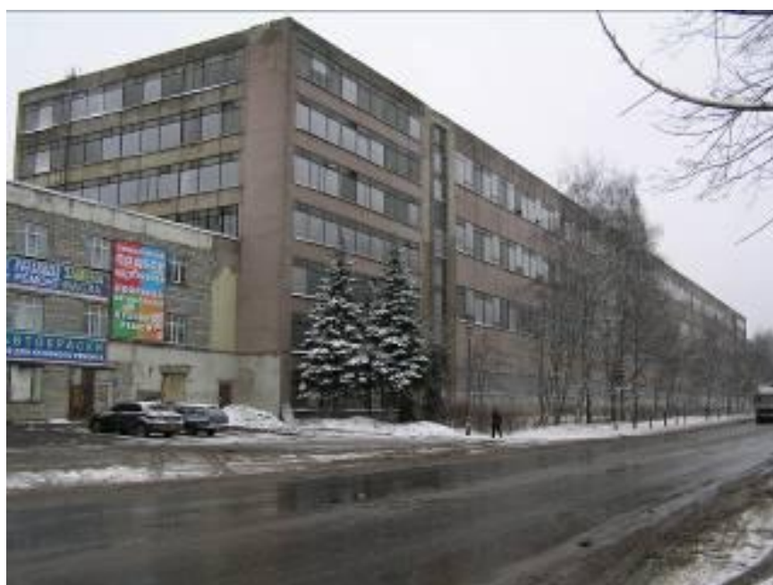
Фото производственного здания
