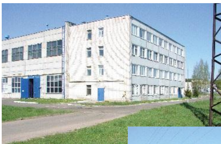
Административно-бытовая часть цехового помещения
