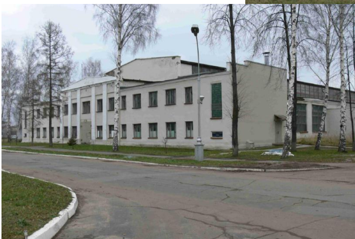
Административно-бытовая часть цехового помещения
