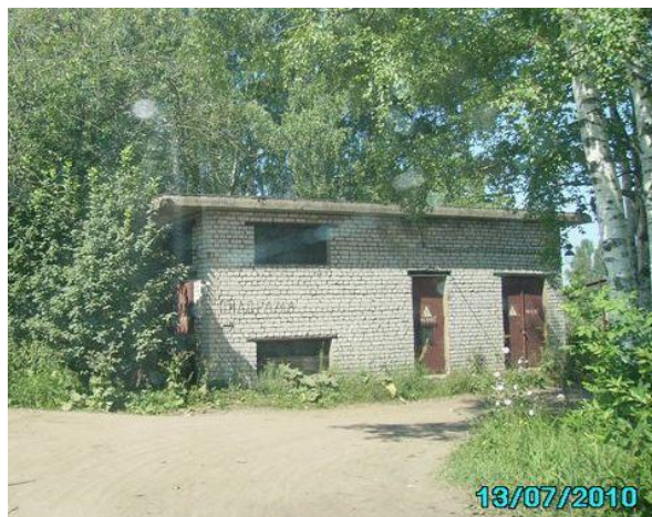
Здание трансформаторной подстанции
