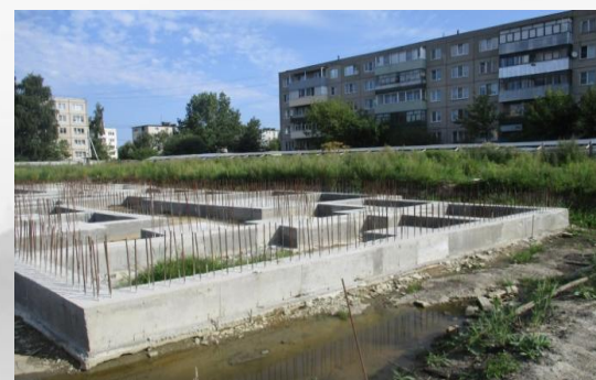
Суркова, 15-17 Договор заключен на три года (до 12.05.2024) Завершение жилищного строительства
