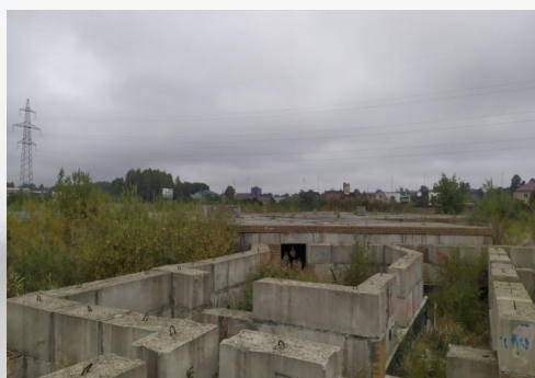
Приборостроителей, 26 Подготовка к проведению торгов Жилищное строительство
