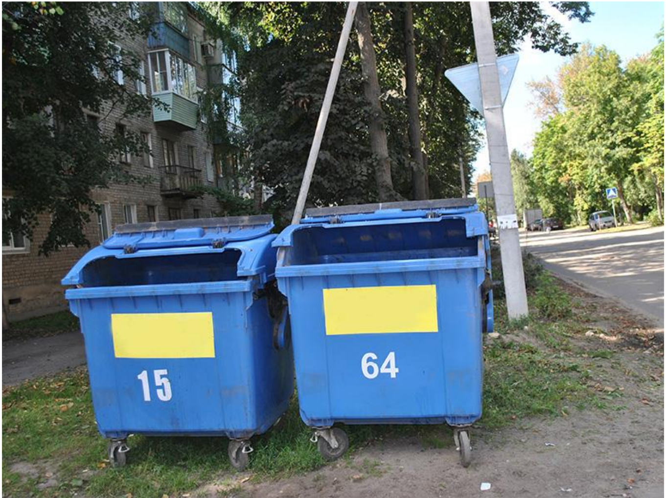
Контейнерная площадка никак не оборудована, отсутствует ограждение, а также бетонная площадка
